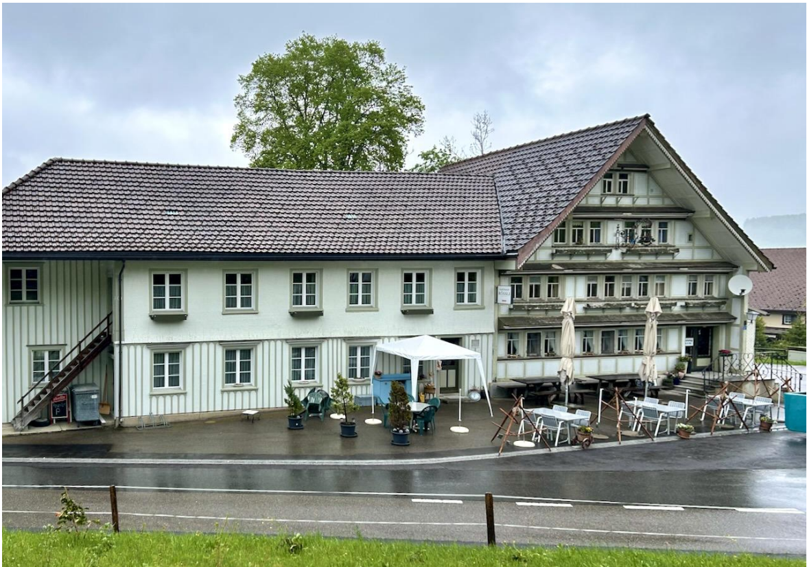
Abb. 8: Das Gasthaus Rüssli, südwestlich der Strassenkreuzung, ist als Kulturobjekt verzeichnet.
