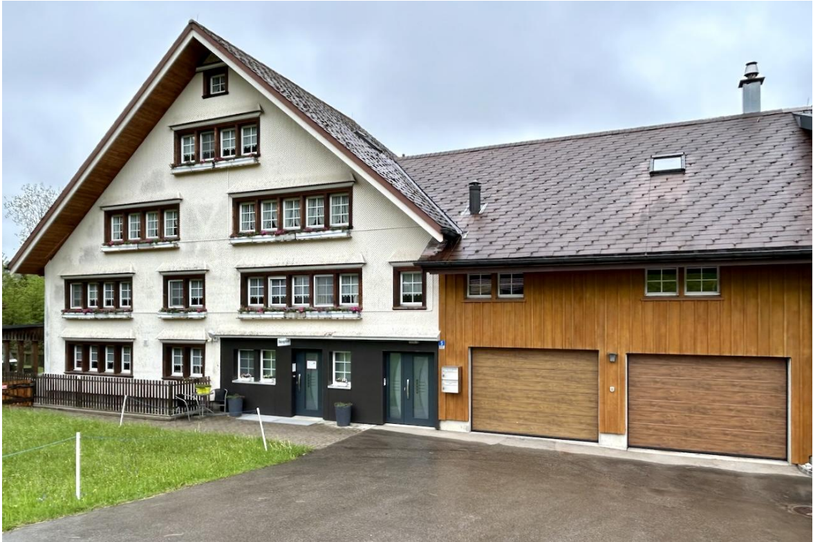
Abb. 9: Einfamilienhaus im nördlichen Teil des Dorfs Bächli (nordwestlich des Perimeters gelegen).
