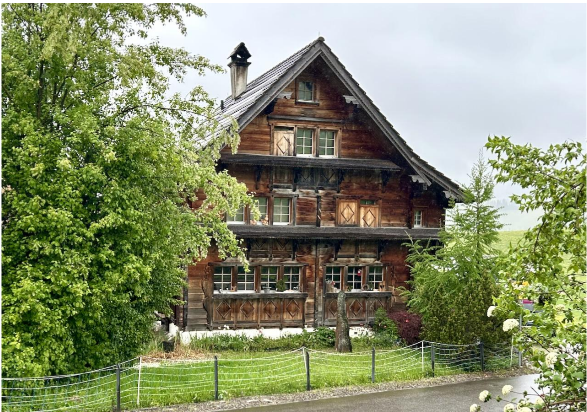
Abb. 12: Einfamilienhaus im nördlichen Teil des Dorfs Bächli (nordwestlich des Perimeters gelegen).
