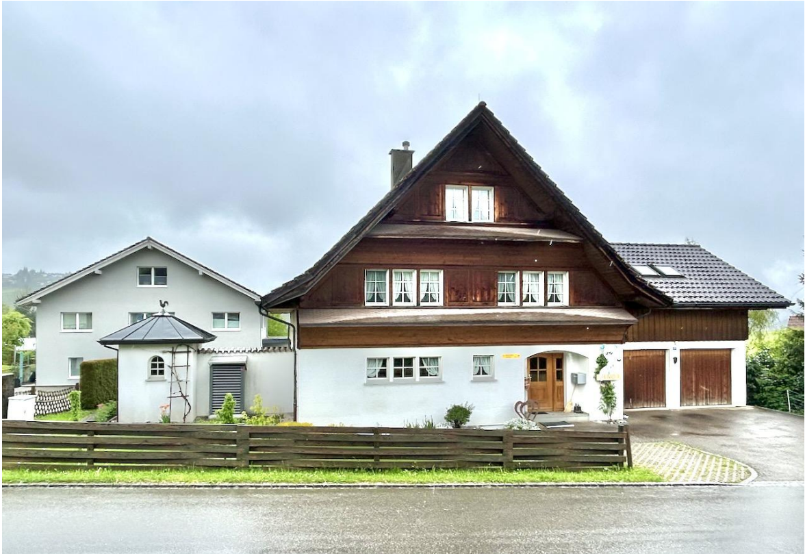
Abb. 11: Einfamilienhäuser im nördlichen Teil des Dorfs Bächli (nordwestlich des Perimeters gelegen).
