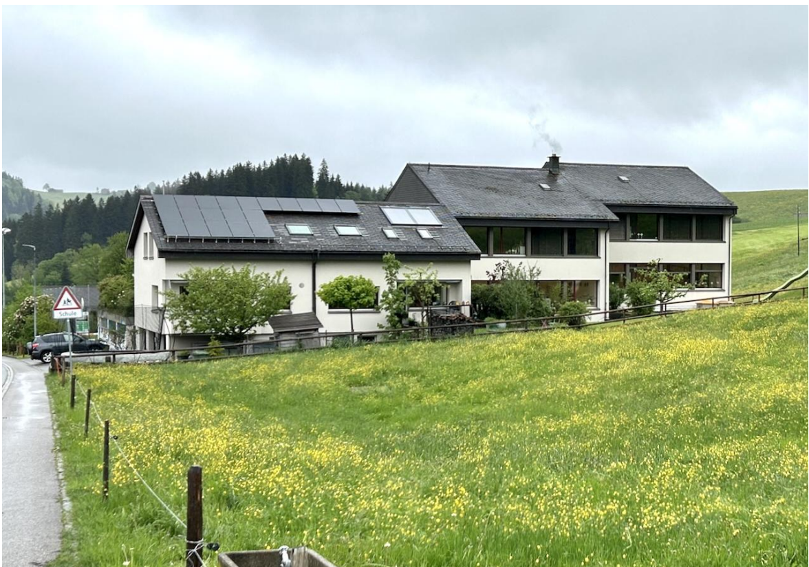
Abb. 4: Sicht von Süden her Richtung Schulhaus (rechts) mit dazugehörigem EFH (links). Beide Gebäude liegen ausserhalb des SNP-Perimeters.
