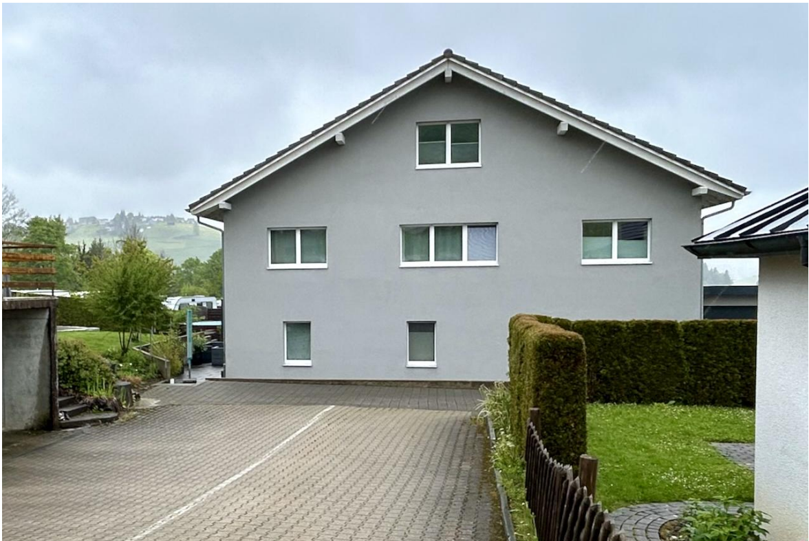
Abb. 10: Einfamilienhaus im nördlichen Teil des Dorfs Bächli (nordwestlich des Perimeters gelegen).
