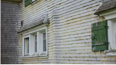
0724 Detail der Verschindelung
