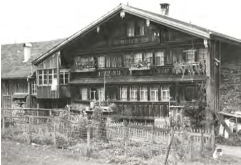
1051 Hauptfassade dd. 1981 (Inventar 1981)
