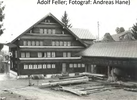
1016 Hauptfassade dd. 1981 (Inventar 1981)
