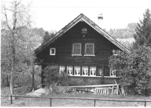
1006 Hauptfassade dd. 1981 (Inventar 1981)
