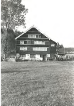
1039 Hauptfassade dd. 1981 (Inventar 1981)
