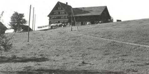
1026 Hauptfassade dd. 1981 (Inventar 1981)
