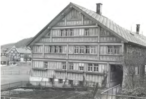
1092 Hauptfassade dd. 1981 (Inventar 1981)
