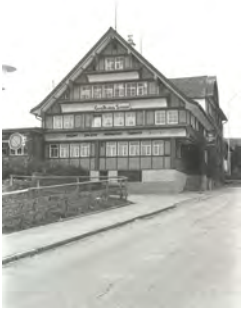
1083-1 Hauptfassade dd. 1981 (Inventar 1981)
