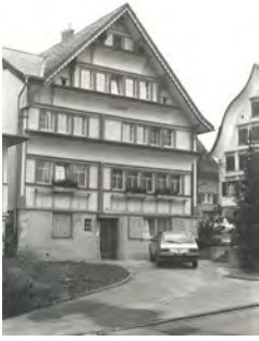
1075 Hauptfassade dd. 1981 (Inventar 1981)
