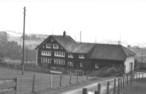
1052 Hauptfassade dd. 1981 (Inventar 1981)
