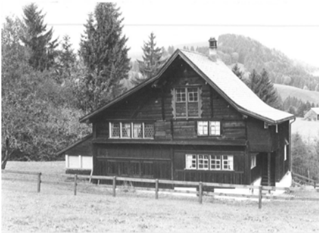
1005 Hauptfassade dd. 1981 (Inventar 1981)
