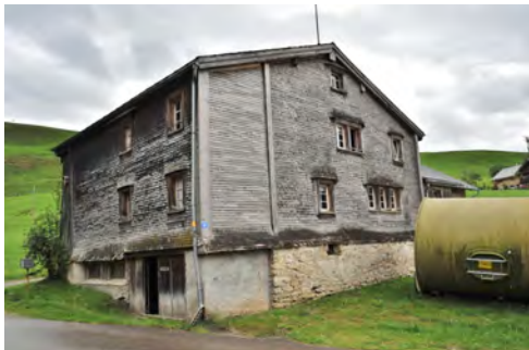
0600 Nordwestliche Giebelfassade und Nordöstliche Trauffassade
