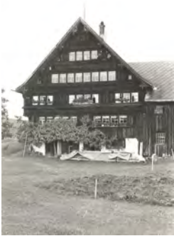
1014 Hauptfassade dd. 1981 (Inventar 1981)
