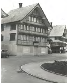
1077 Hauptfassade dd. 1981 (Inventar 1981)
