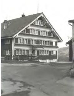
1086 Hauptfassade dd. 1981 (Inventar 1981)
