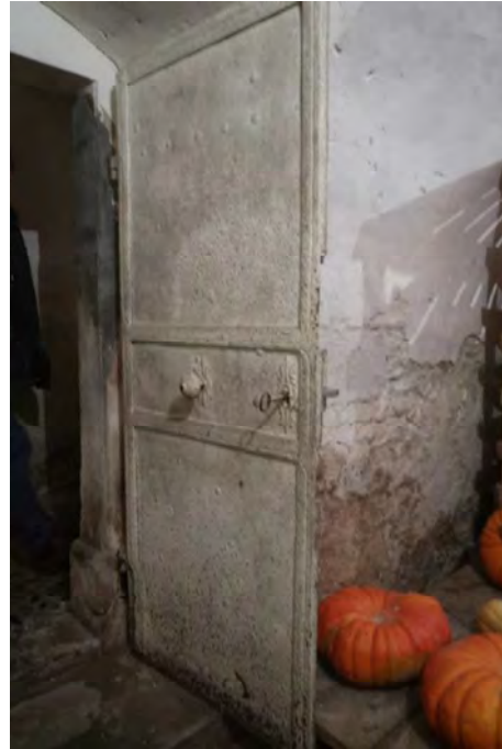
Eisentüren im Gewölbekeller
