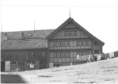
1028 Hauptfassade dd. 1981 (Inventar 1981)
