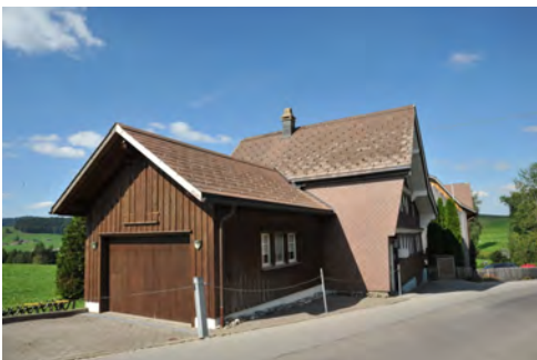
0295 Späterer Anbau an der Südwestfassade
