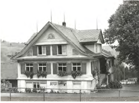
1047 Hauptfassade dd. 1981 (Inventar 1981)
