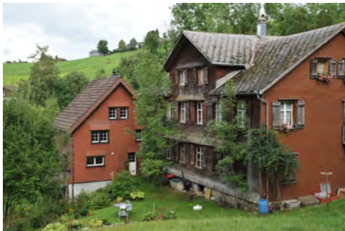
0480 Seitenfassade (linkes Gebäude)
