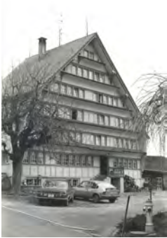
1068-2 Hauptfassade dd. 1981 (Inventar 1981)
