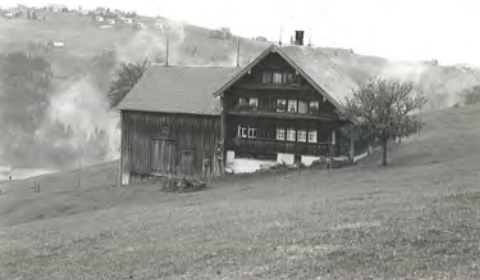
1042 Hauptfassade dd. 1981 (Inventar 1981)
