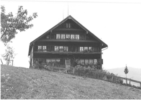
1017 Hauptfassade dd. 1981 (Inventar 1981)
