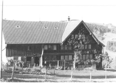
1032 Hauptfassade dd. 1981 (Inventar 1981)
