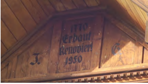
0731 Inschrift mit Bau- und Renovierungsdatum
