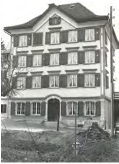
1082-1 Hauptfassade dd. 1981 (Inventar 1981)
