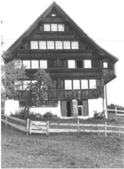
1013 Hauptfassade dd. 1981 (Inventar 1981)
