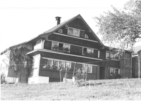
1025 Hauptfassade dd. 1981 (Inventar 1981)
