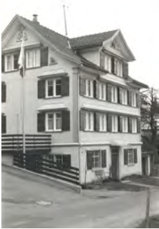
1070-2 Hauptfassade dd. 1981 (Inventar 1981)
