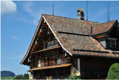
0242 Detail des Giebeldreiecks
