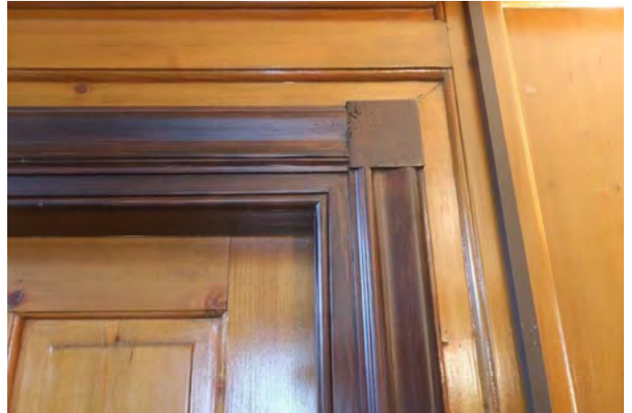
Nadelholztüren im 2. OG/3. OG. Ursprünglich gefasst, heute holzsichtig.
