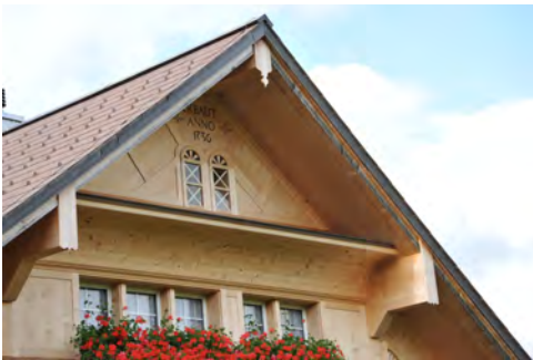
0495 Detail der hauptfassade
