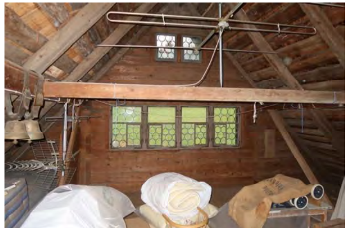
Dachkammer mit Butzenscheiben. Die Blockwände der Kammer sind entfernt.
