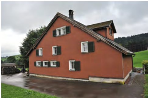
0382 Ansicht vom Nordosten
