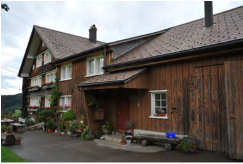
0634 Teilweise umgebaute Ökonomie
