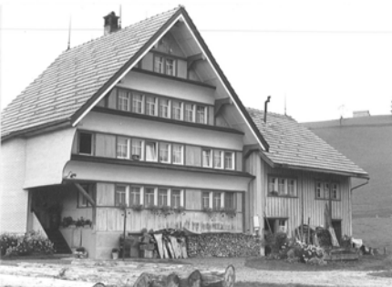
1040 Hauptfassade dd. 1981 (Inventar 1981)
