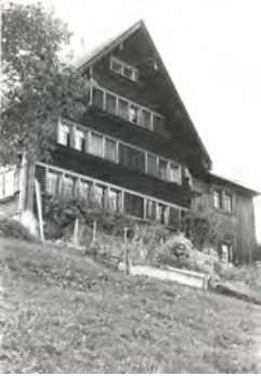
1060-2 Hauptfassade dd. 1981 (Inventar 1981)
