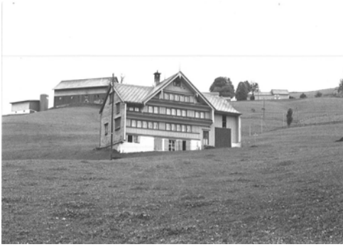
1048 Hauptfassade dd. 1981 (Inventar 1981)
