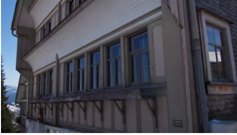
0866 Detail der Doppelfenster
