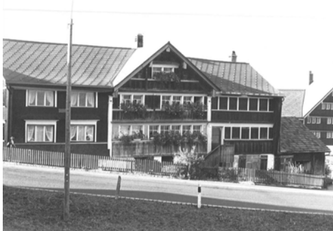
1029 Hauptfassade dd. 1981 (Inventar 1981)
