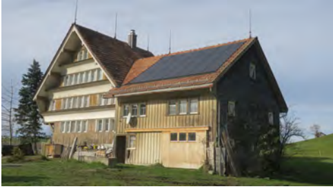
0718 Ökonomie mit Photovoltaikanlage
