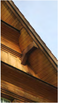
0735 Detail des Dachüberstandes
