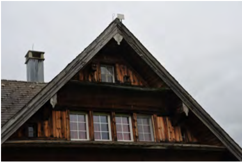
0576 Detail des Giebeldreiecks
