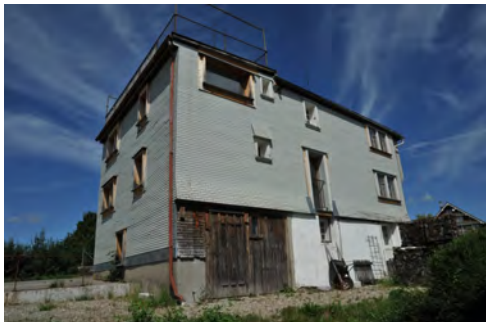
0186 Hinter- und Seitenfassade
