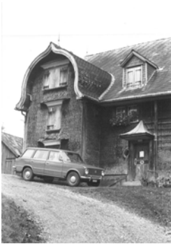
1060-1 Anbau mit Risalit mit geschweiftem Giebel dd. 1981 (Inventar 1981)
