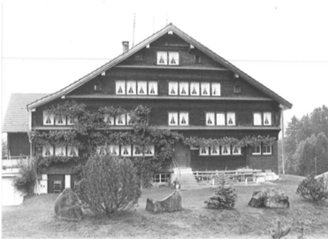
1044 Hauptfassade dd. 1981 (Inventar 1981)
