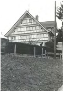
1074 Hauptfassade dd. 1981 (Inventar 1981)
