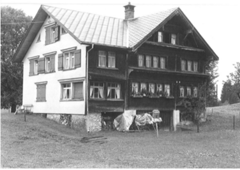
1002 Hauptfassade dd. 1981 (Inventar 1981)
