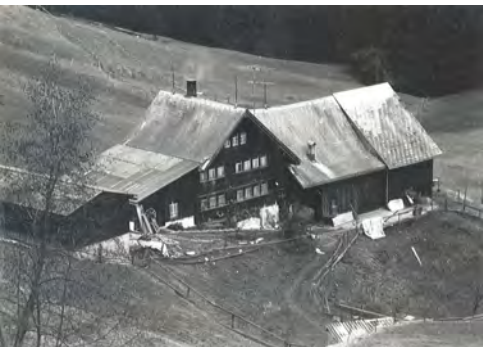
1066-2 Hauptfassade dd. 1981 (Inventar 1981)
