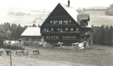
1004 Hauptfassade dd. 1981 (Inventar 1981)
