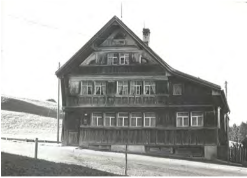
1030 Hauptfassade dd. 1981 (Inventar 1981)
