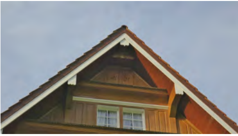
0774 Detail der Dachvorstand
