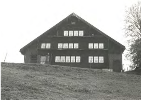
1003 Hauptfassade dd. 1981 (Inventar 1981)
