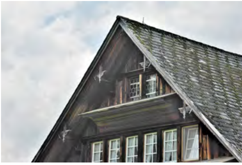
0410 Detail der Dachvorstand
