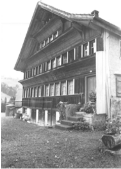
1049 Hauptfassade dd. 1981 (Inventar 1981)
