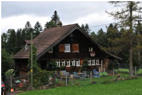
0364 Ansicht vom Süden.
