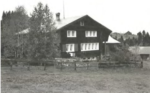
1019 Hauptfassade dd. 1981 (Inventar 1981)
