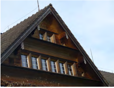
0824 Detail des Giebeldreiecks
