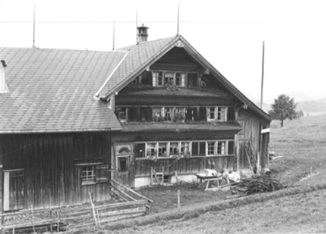
1053 Hauptfassade dd. 1981 (Inventar 1981)
