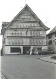
1076 Hauptfassade dd. 1981 (Inventar 1981)
