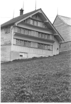
1045 Hauptfassade dd. 1981 (Inventar 1981)
