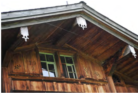
0602 Tätschdach mit Vorschutz mit verzierten Pfettenstirnbretter
