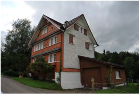
0450 Südöstliche Hauptfassade und nordöstliche Seitenfassade
