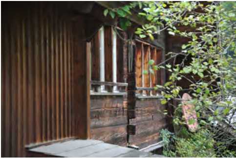
0536 Detail des Blockbaus
