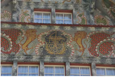
0217 Detail der Hauptfassade
