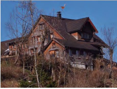
0884 Hinter- und talseitige Seitenfassade
