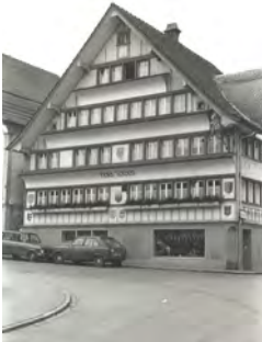
1078 Hauptfassade dd. 1981 (Inventar 1981)
