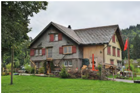
0377 Ansicht von Norden
