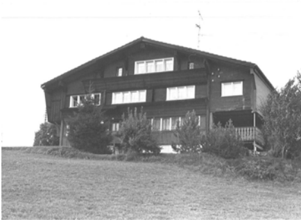
1021 Hauptfassade dd. 1981 (Inventar 1981)
