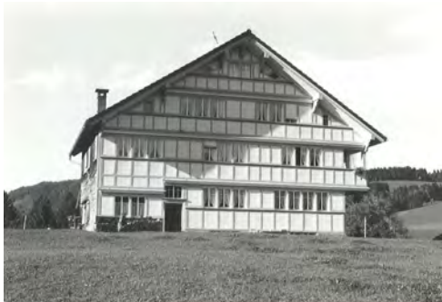
1022 Hauptfassade dd. 1981 (Inventar 1981)
