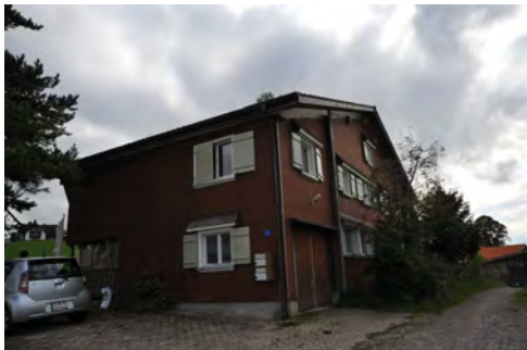
0433 Hinterfassade an der Strassenseite
