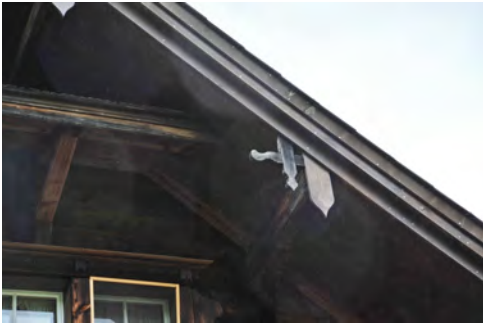
0353 Detail der Pfettenkonsole.
