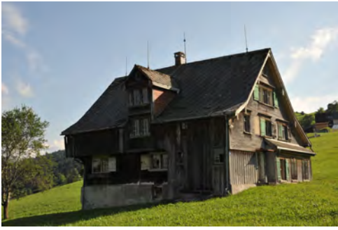
0344 Trauffassade und giebelbetonte Hinterfassade
