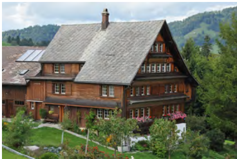
0421 Giebelhauptfront und traufseitige Fassade mit Eingang
