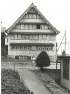
1071 Hauptfassade dd. 1981 (Inventar 1981)
