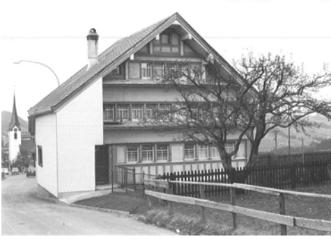
1090 Hauptfassade dd. 1981 (Inventar 1981)
