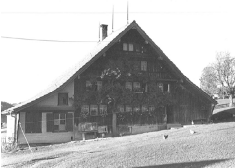
1033 Hauptfassade dd. 1981 (Inventar 1981)
