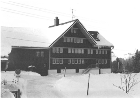
1097 Hauptfassade dd. 1981 (Inventar 1981)
