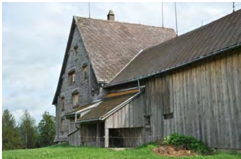
0418 Ansicht vom Nordwesten.
