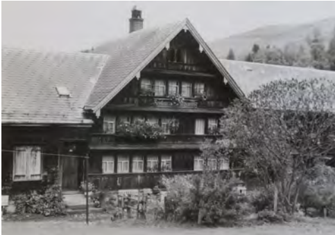
1057-2 Hauptfassade dd. 1981 (Inventar 1981)
