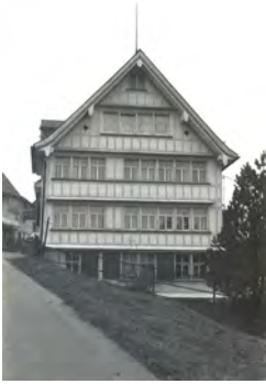
1073 Hauptfassade dd. 1981 (Inventar 1981)
