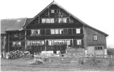
1009-2 Hauptfassade dd. 1981 (Inventar 1981)
