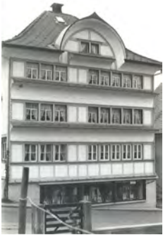
1081-2 Hauptfassade dd. 1981 (Inventar 1981)
