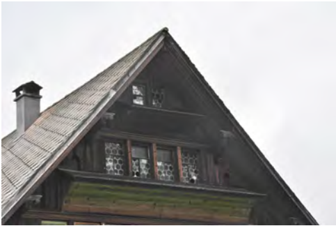
0371 Detail der Fenster mit Bleiverglasung in den Dachgeschossen
