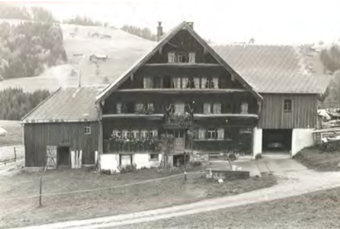
1001 Hauptfassade dd. 1981 (Inventar 1981)
